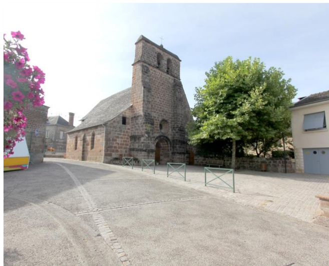
Les aménagements réalisés dans le bourg valorisent le patrimoine
