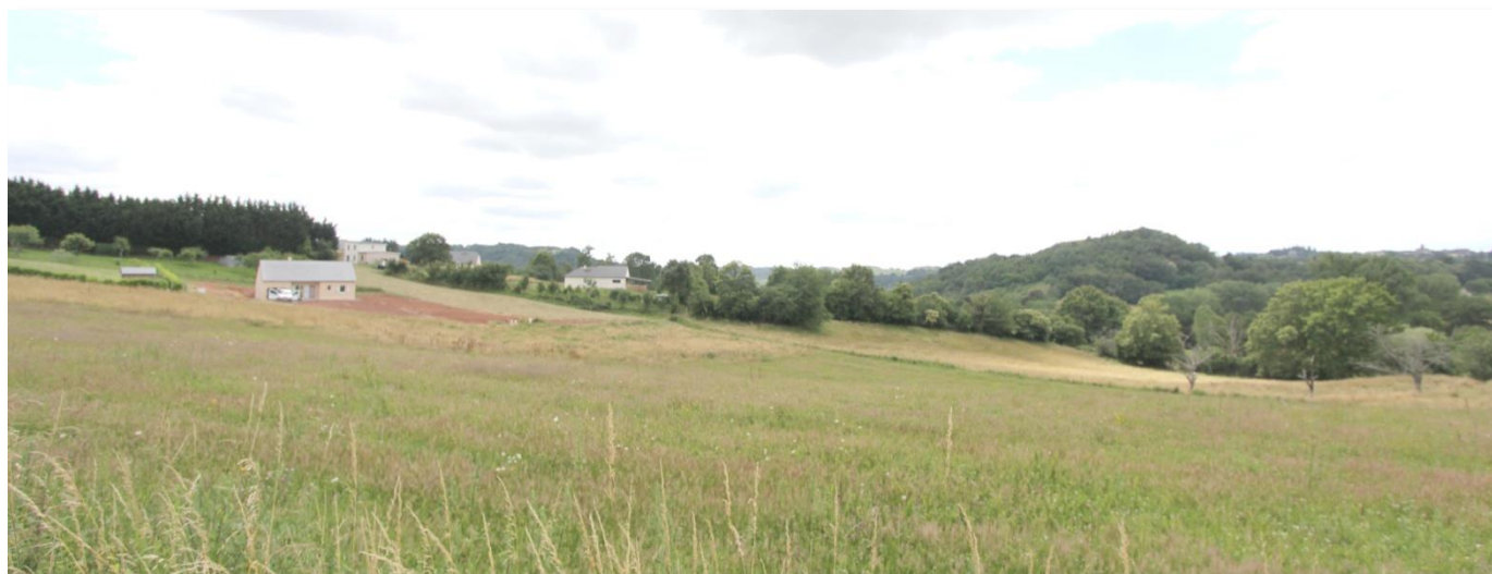
Vue sur les nouveaux développements d'Ayen, se trouvant en limite de zone de covisibilité
