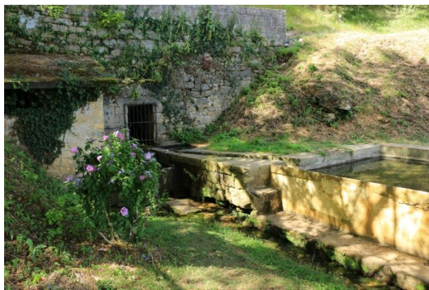
Source du ruisseau de la Peyrède aménagée et située au nord de Perpezac-le-Blanc
