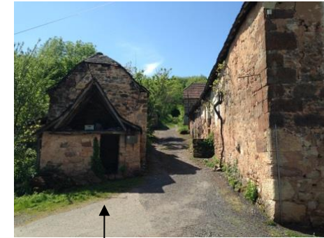
Ancien hangar agricole
